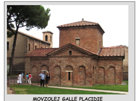
MOVZOLEJ GALLE PLACIDIE
